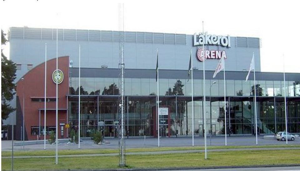
Gavlerinken 1967 > Läkerol Arena 2006 > Gavlerinken Arena 2014.
