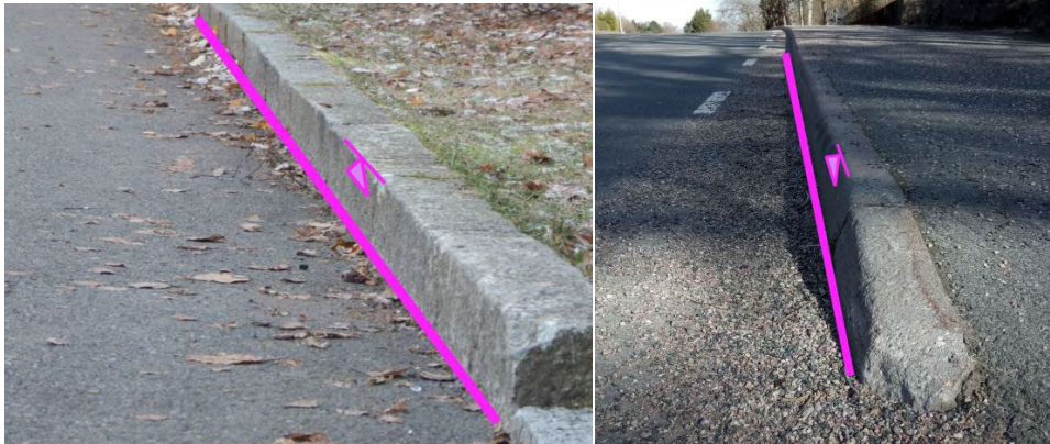
Figur 3.1. Exempel på mätningsanvisningar [2]. Av anvisningarna framgår att objekttypen "kantsten" ska mätas in som en linje bildad av två (eller flera) punkter där höjden på objektet anges relativ underkant.
