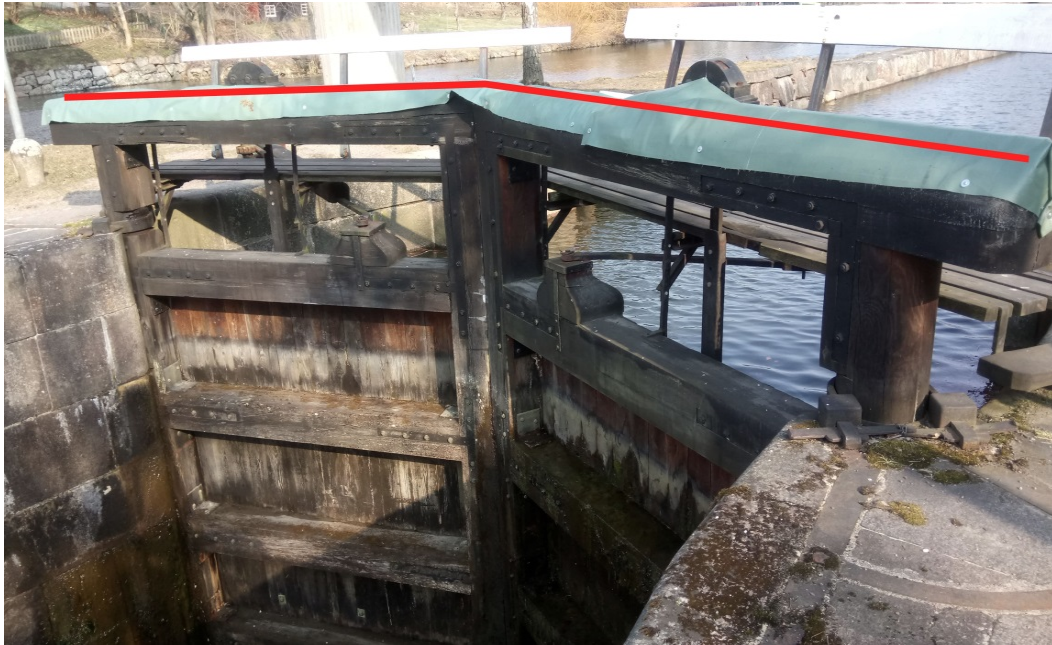
Figur D.2.1f. Slussport mäts genom slussportarna i stängt läge.
